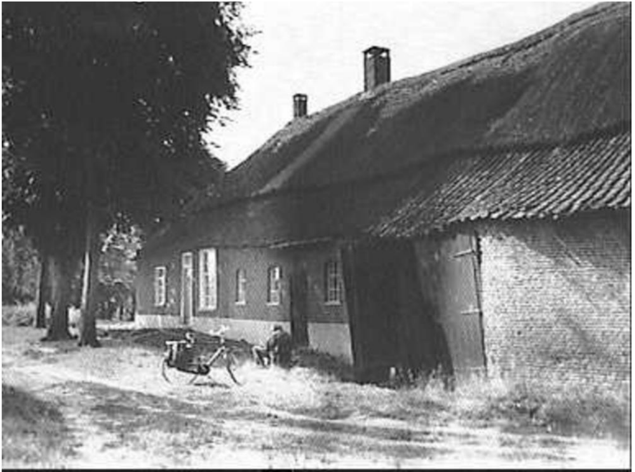
foto van de Zandhoeve in 1984
